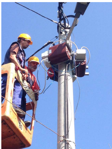
Slika 2. Primjer montaže „sistema VROT-18“
